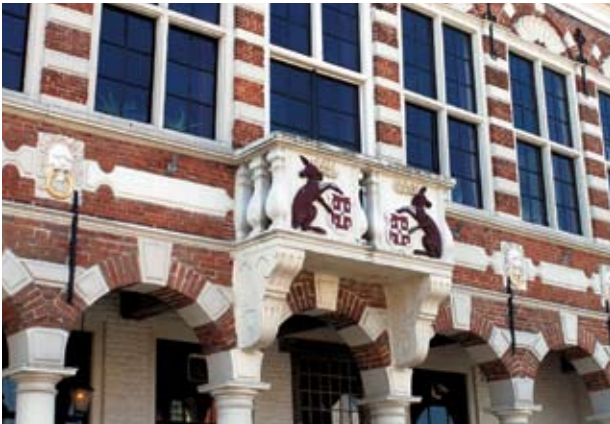
Het stadhuisbalkon van Vollenhove uit 1621. Op een oude tekening is boven het balkon van het stadhuis van Vollenhove ook nog een baldakijndak aanwezig. Sporen in de gevel van het stadhuis van Hattem duiden hier eveneens op.
