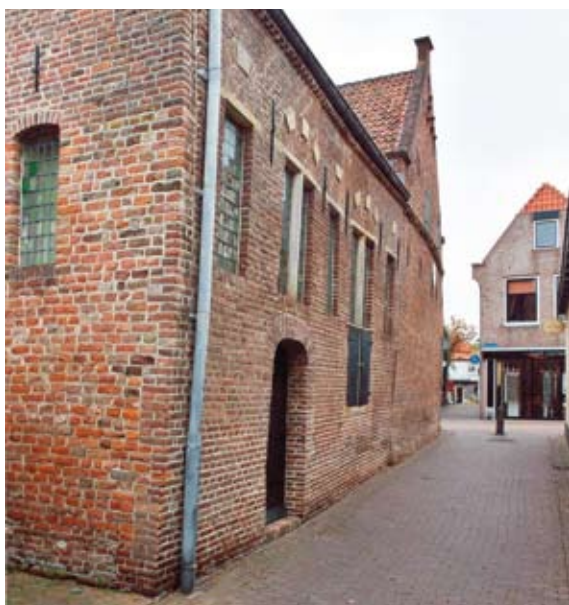
Het eerste project van de Stichting Stadskern Hattem. De tot winkel herbestemde stadsboerderij aan de Kerkstraat 27, gezien vanuit de Derde Walsteeg.
