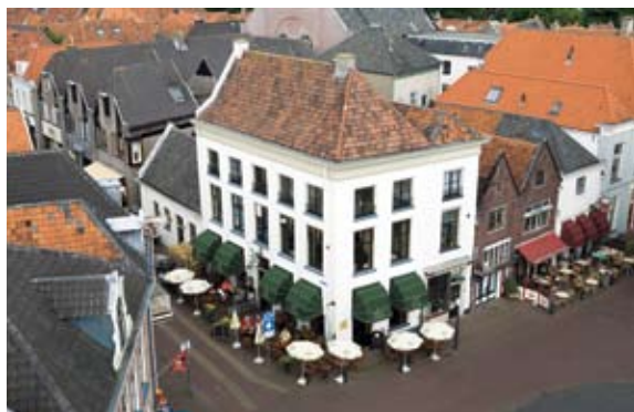
Op de hoek van de Markt en de Kerkstraat staat het pand "de Zon". Dit pand werd in de jaren 1978/79 door de stichting gerestaureerd en kreeg toen zijn vroegere horecabestemming terug. Hier is thans de brasserie "de Zwarte Truffel" in gevestigd.
